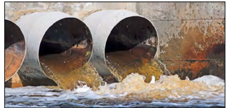
Bild 1: Einleitung von verschmutztem Abwasser in einen Fluss
